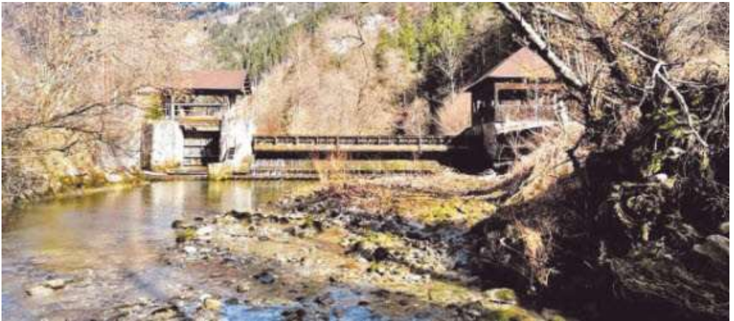
Im Visier der Behörden: Kraftwerk St. Martin am Thörlbach KK
